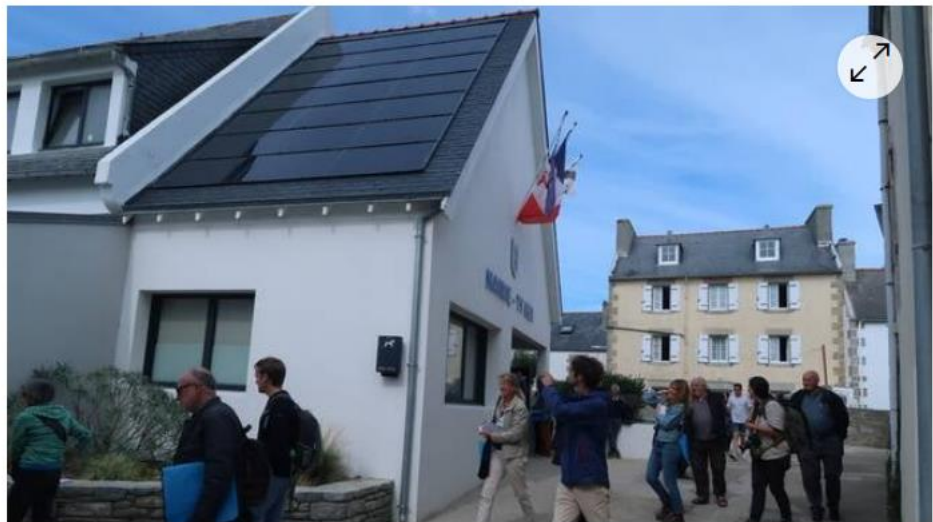
Des panneaux photovoltaïques d'une superficie de 46 m 2 sont installés depuis 2021 sur la mairie de Sein. | OUEST-FRANCE
