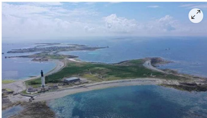
En 2024, l'île de Sein devrait couvrir 65 % de ses besoins en énergie grâce à l'éolien et au solaire. | OUEST-FRANCE
