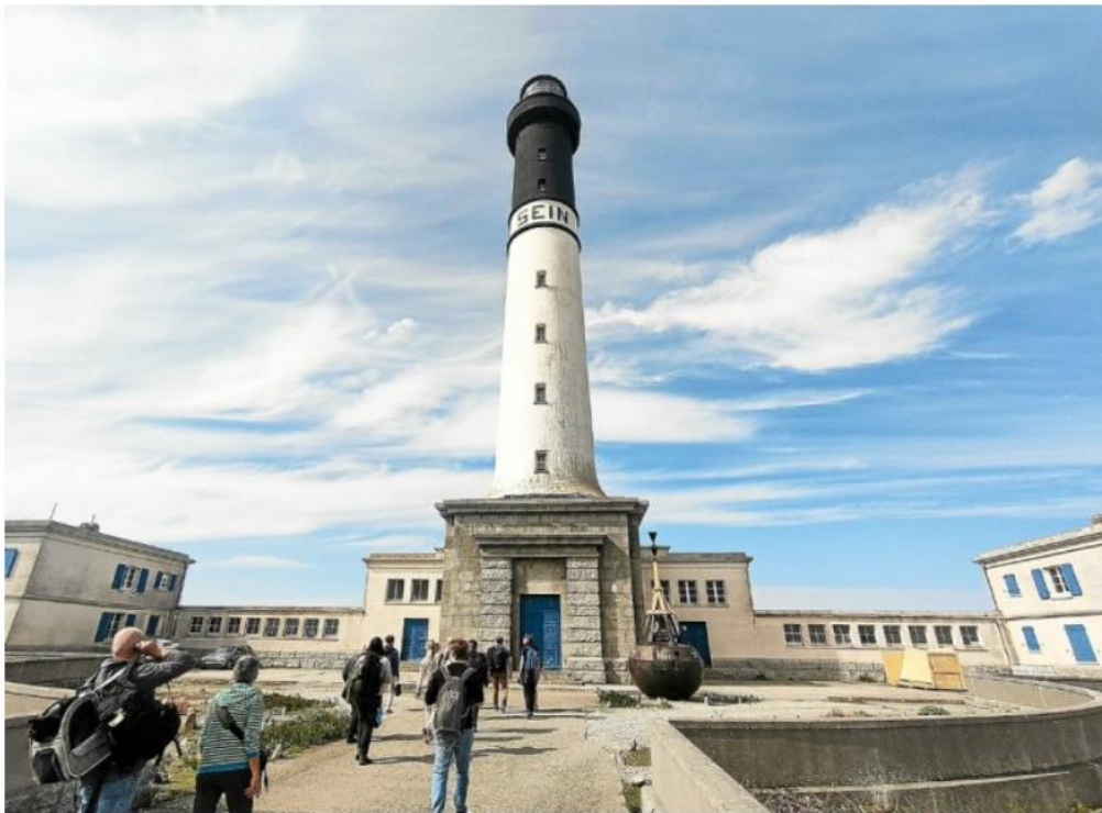
Les groupes électrogènes et les batteries de stockage sont installés dans le grand phare de l'île de Sein. (Le Télégramme/Dimitri L'hours)
