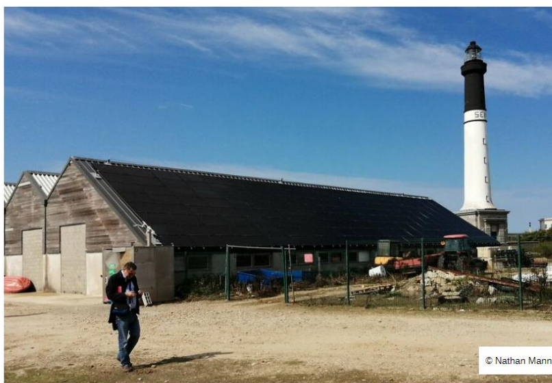
Installés en 2017, les 517 mètres carrés de panneaux solaires qui recouvrent l'ancienne écloserie à homards de l'île de Sein sont noirs pour se fondre dans le paysage.
