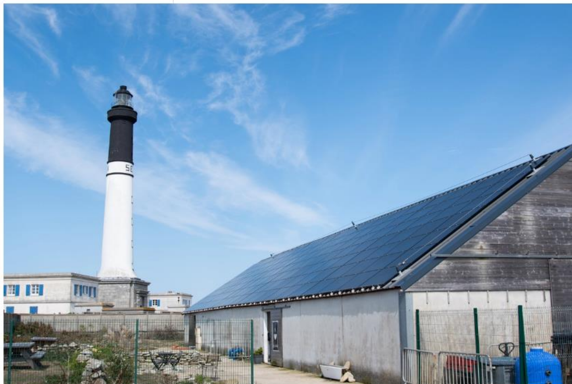
Des panneaux photovoltaïques sur un bâtiment et le phare où se situe la centrale thermique de l'île (fioul). © Morgan Bisson / Hans Lucas / Reporterre
